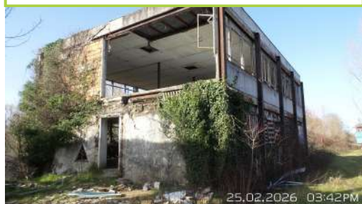
important bâtiment en béton armé
